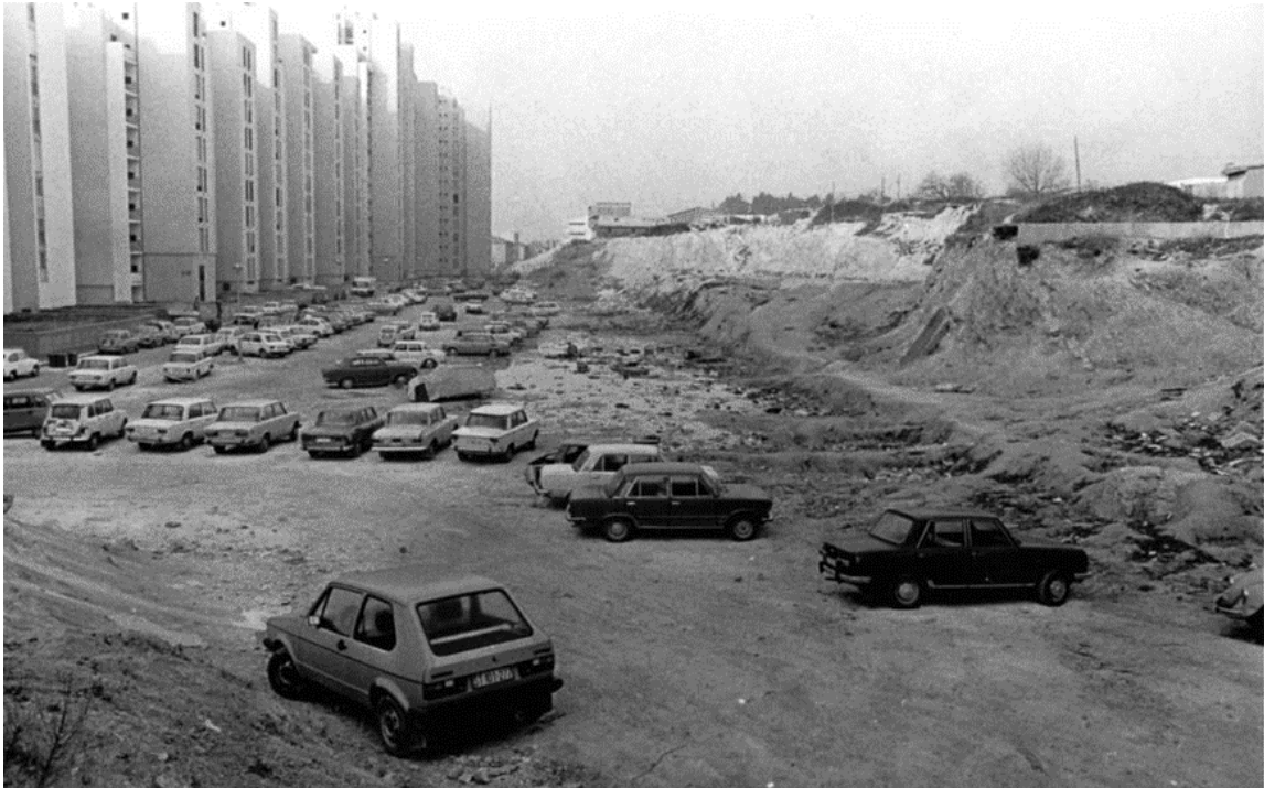
Slika 21. Parking na Sućidru, 1983.
