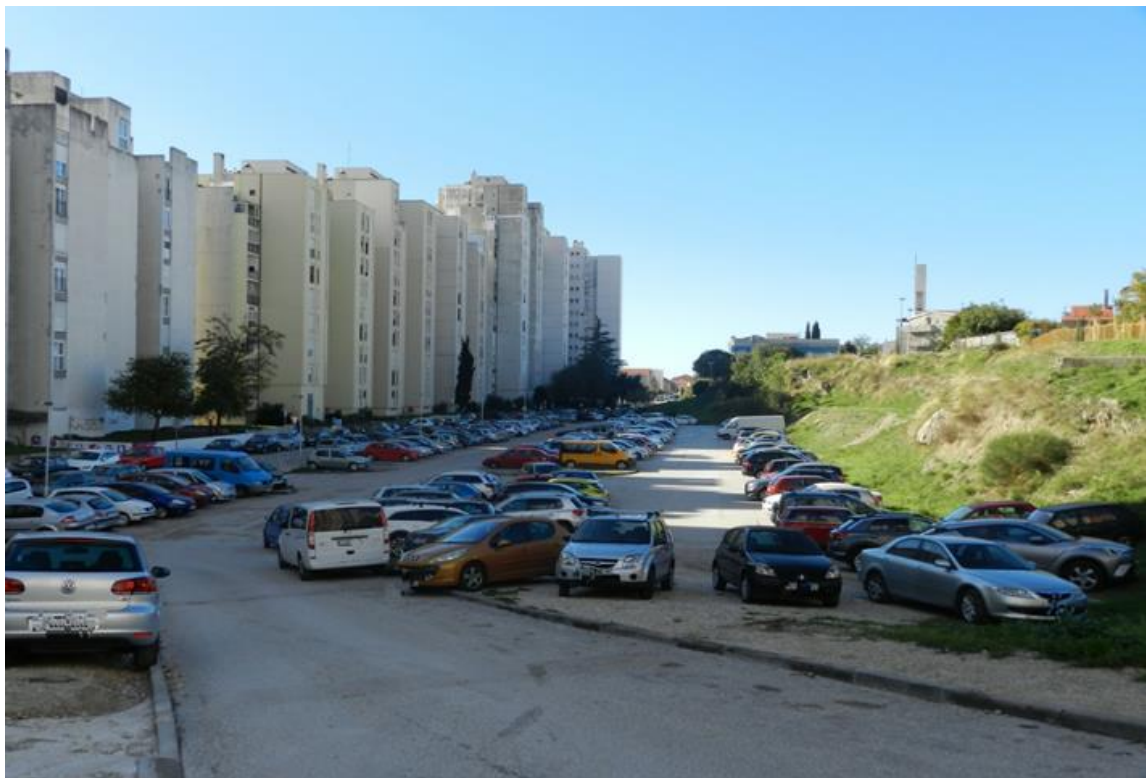
Slika 22. Parking na Sućidru, 2023.
