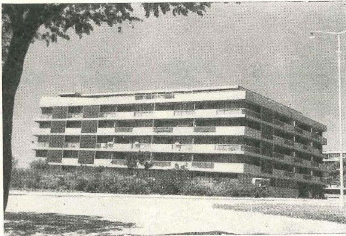
Slike 8. Stambeni blok na Bačvicama, Stanko Fabris
