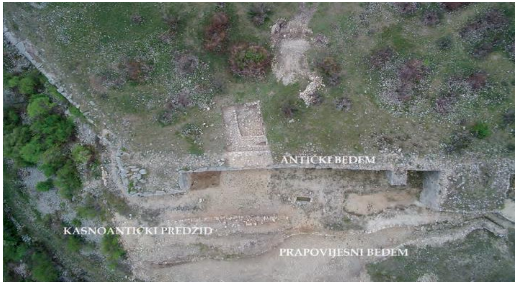
Slika 20. Fotografija sjeverne strane fortifikacijskog kompleksa sa jasno naznačenim dijelovima iz različitih perioda
