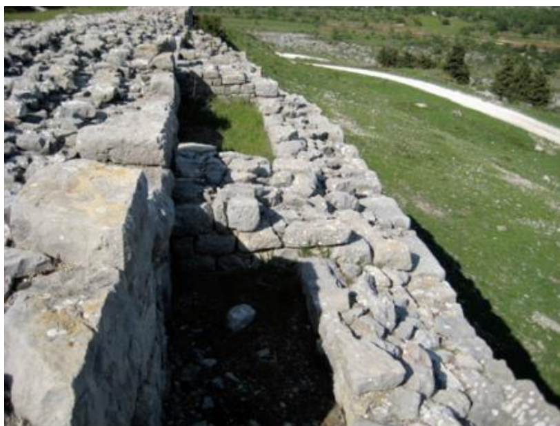
Slika 19. Fotografija potpornjaka povezanih zidom
