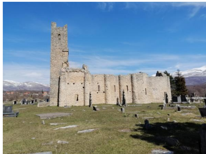
Slika 35. Južno pročelje (Foto: Marko Kojundžić)
