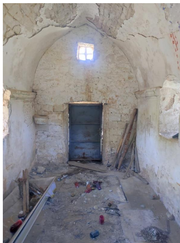
Slika 68. Unutrašnji izgled grobišne kapele (Foto: Marko Kojundžić)
