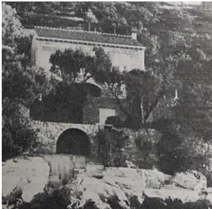
Slika 72. Pogled na istočno pročelje kuće za odmor u Lozici (preuzeto: Marinković, F., 1980., str. 16.)
