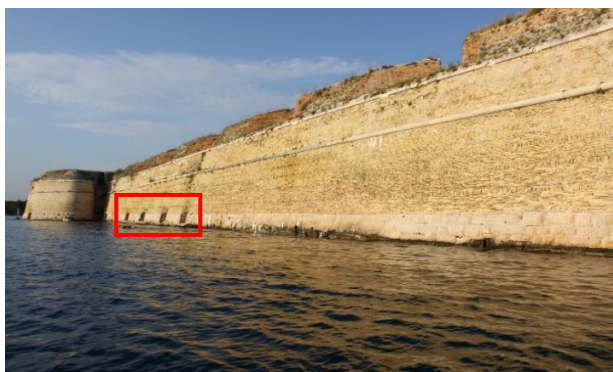
Slika 39. Pogled na zapadnu kortinu tvrđave sv. Nikole, četiri topovska otvora
