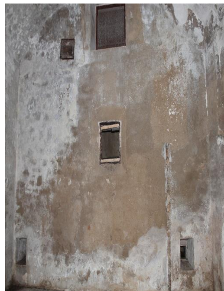
Slika 45. Detalj začelnog zida barutane
