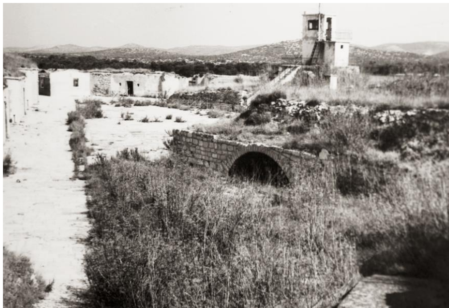
Slika 55. Pogled na signalnu stanicu na tvrđavi sv. Nikole, 1971. godine
