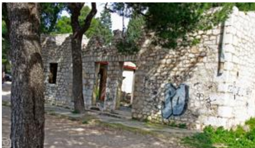
Slika 79. Ruševni ugostiteljski objekt s plesnom terasom
