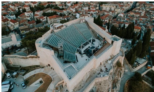
Slika 35. Snimak tvrđave sv. Mihovila iz zraka, pogled na pozornicu
