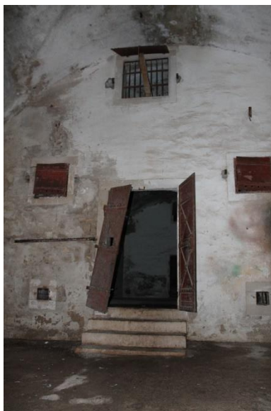
Slika 43. Detalj pročelnog zida barutane
