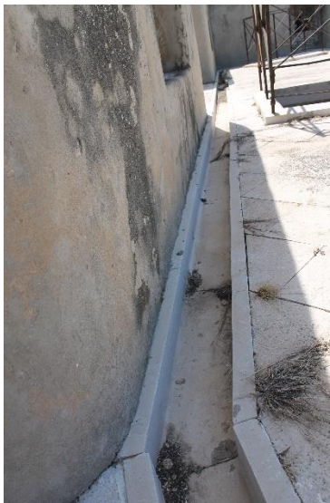
Slika 41. Detalj odvodnje kišnice na bastionu tvrđave sv. Mihovila
