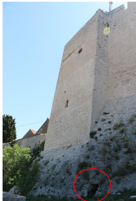
Slika 32. Otvor na sjeveroistočnom bedemu kaštela
