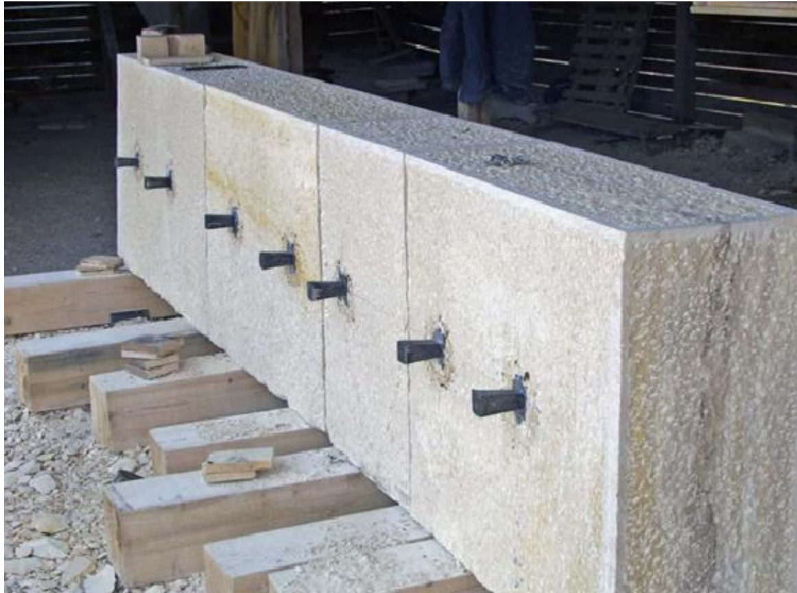
Slika 10. Red isklesanih i pripremljenih kamenih blokova za jedan red luka mosta, ekstrados je gore, ugrađeni klinovi su na naližežućoj strani reda (foto: Ž. Peković). (Preuzeto iz Milošević, Peković, 2009. str.390)
