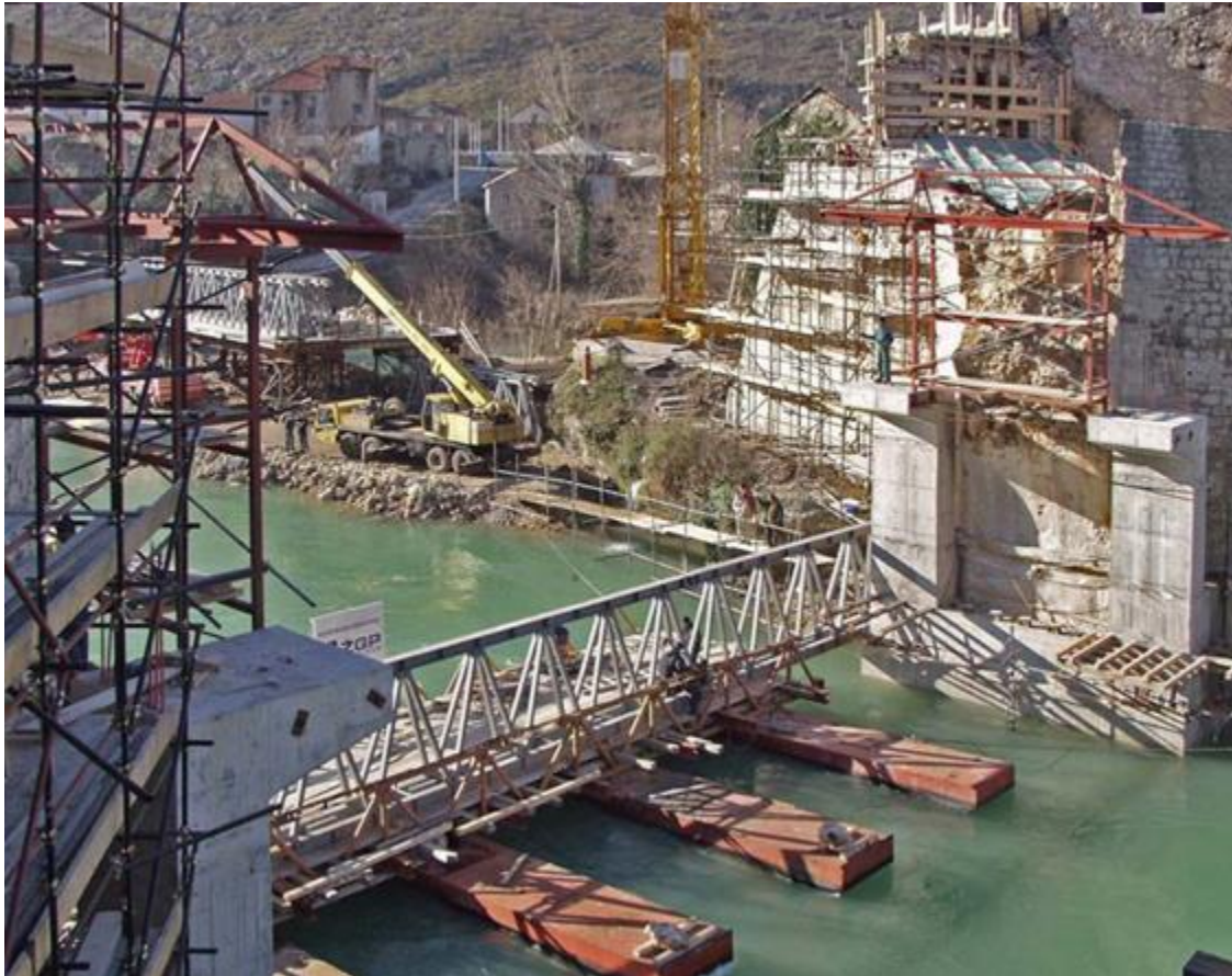
Slika 7. Doprema i montaža nove čelične konstrukcije skele za gradnju kamenog mosta (foto: Ž. Peković). (Preuzeto iz Milošević, Peković, 2009. str.384.)
