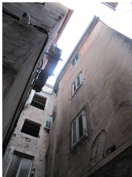
Slika 8 Južni zid zgrade na adresi Krešimirova ulica 7
