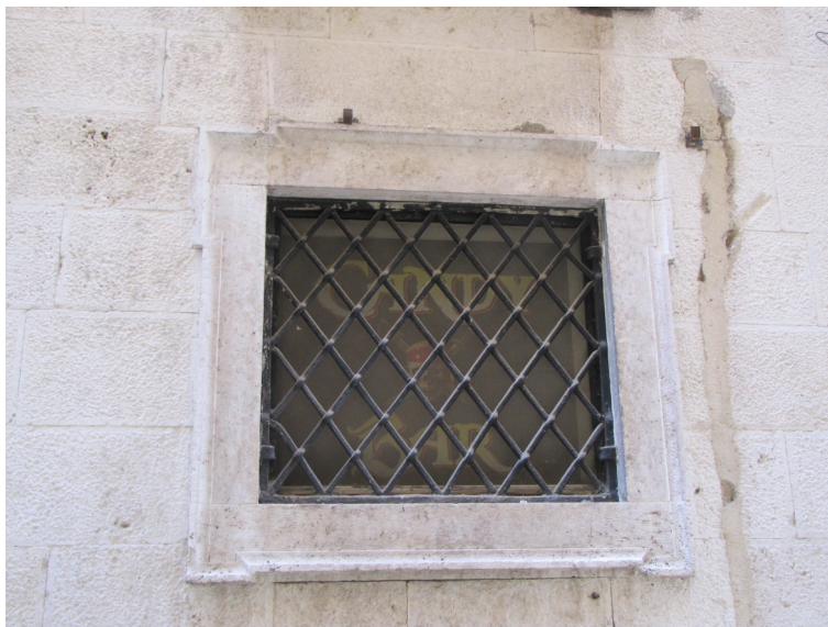
Slika 41 Prozor prizemlja južnog pročelja palače Cindro
