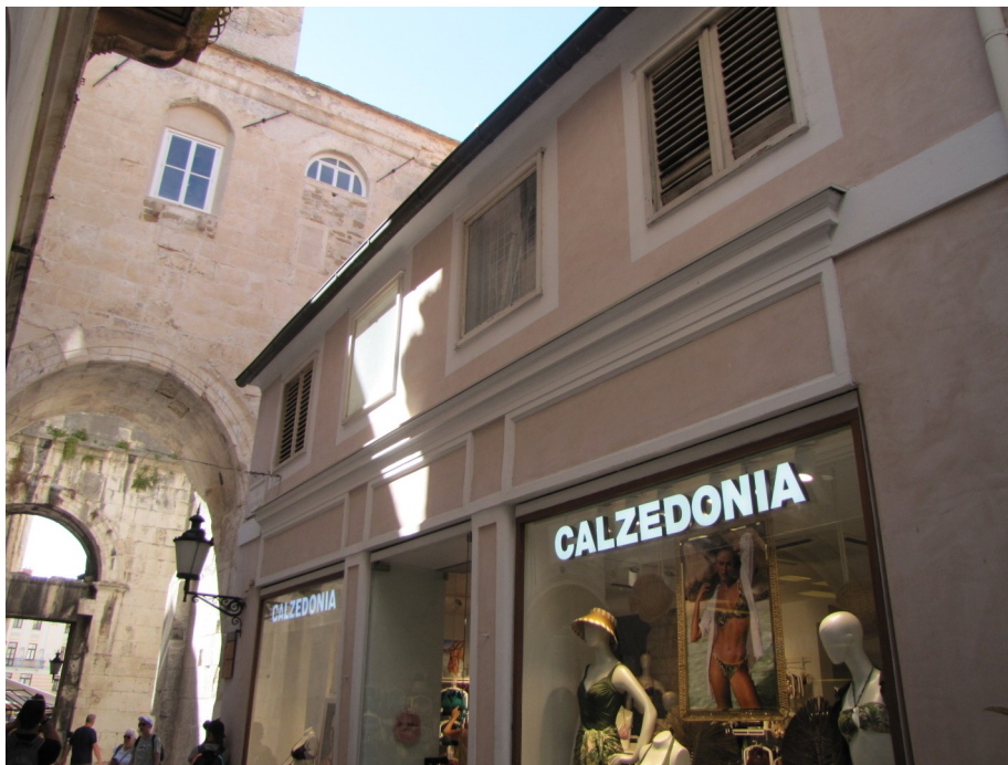
Slika 12 Južno pročelje zgrade na adresi Krešimirova ulica 1
