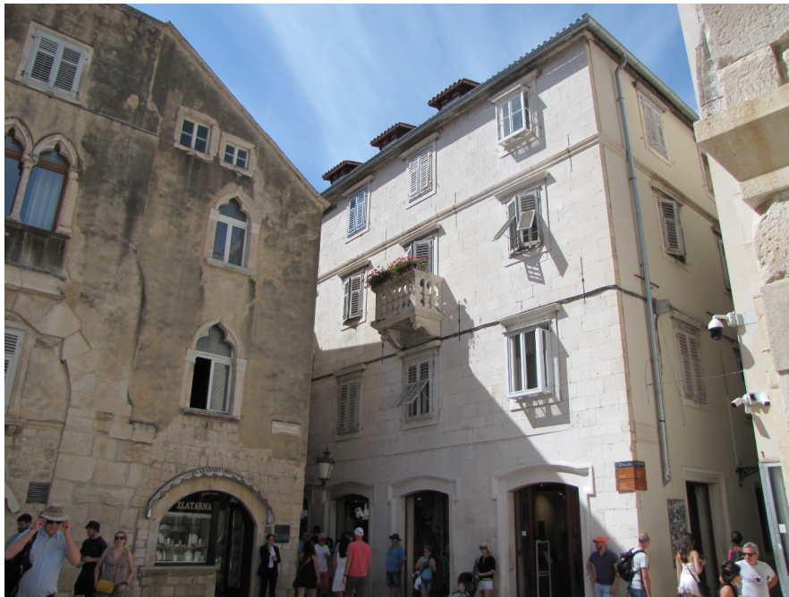
Slika 4 Južno pročelje zgrade na adresi Krešimirova ulica 11
