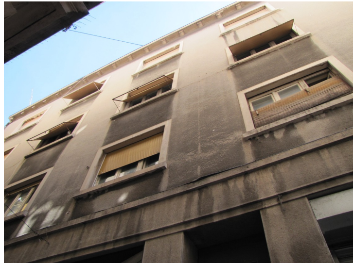
Slika 16 Katovi sjevernog pročelja zgrade na adresama Krešimirova ulica 4 i Krešimirova ulica 6
