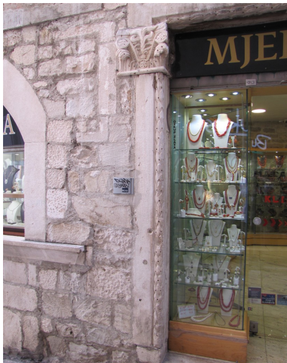
Slika 42 Dovratnik zapadnih ulaznih vrata sjevernoga pročelja palače Grisogono
