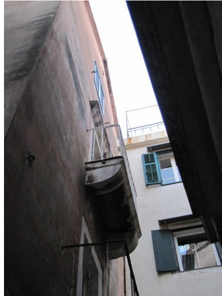
Slika 26 Balkon s istočnoga zida kuće na adresi Krešimirova ulica 7
