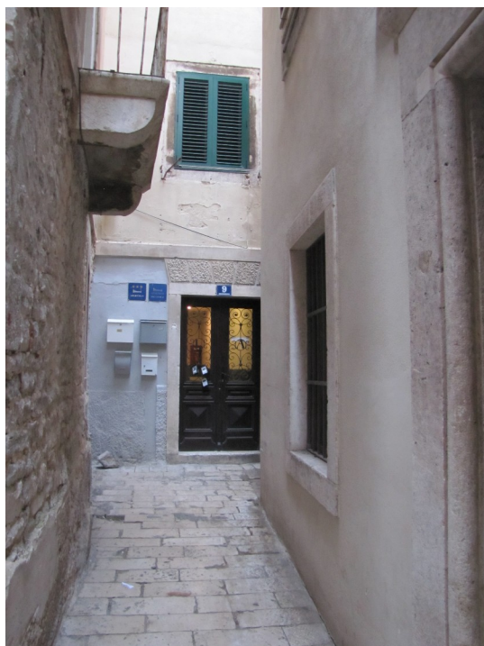
Slika 5 Prizemlje južnog pročelja zgrade na adresi Krešimirova ulica 9
