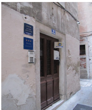
Slika 54 Ulazni portal na istočnome zidu na adresi Krešimirova ulica 5
