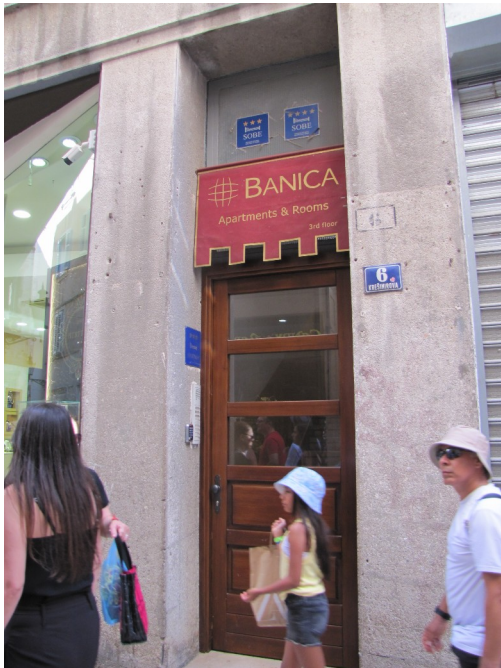
Slika 15 Prizemlje sjevernog pročelja zgrade na adresama Krešimirova ulica 4 i Krešimirova ulica 6
