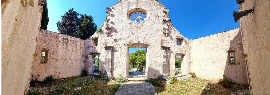
Slika 43. Pogled na unutrašnje zidove
