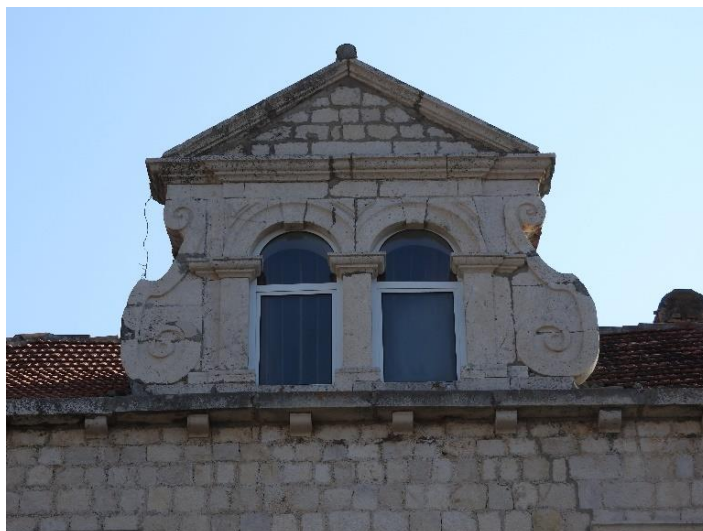
Slika 25. Bifora na kući Bergeljić
