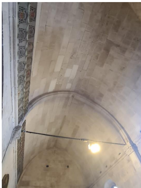
Slika 20. Prelomljeni gotički svod, kojim je presvođena sakristija
