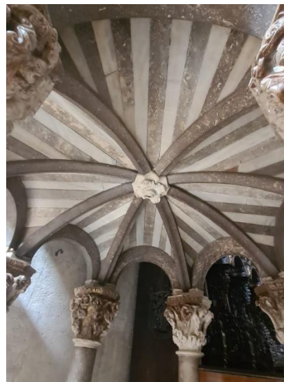
Slika 10. Rebrasti svod propovjedaonice
