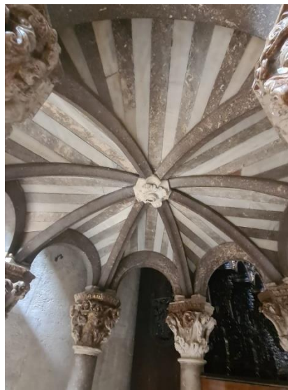
Slika 10. Rebrasti svod propovjedaonice
