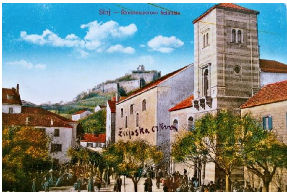
Slika 34. Nedovršeni zvonik i crkva Čudotvorne Gospe Sinjske (Izvor: Marić, 2012., 135)
