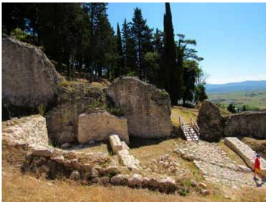
Slika 52. Dio bedema i obrambenog dvorišta uz ulaz na zapadnom bedemu
