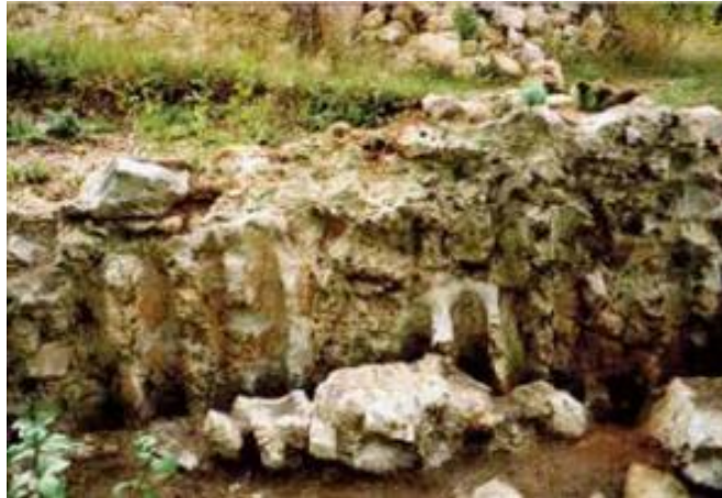
Slika 43. Temelji palisada otkopani 1999. godine
