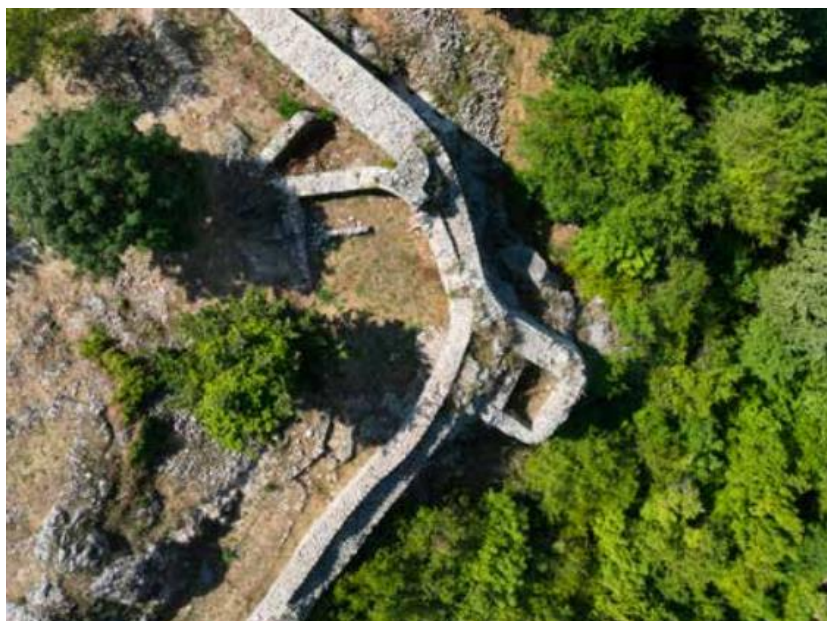
Slika 50. Ostanci cisterne i kule na sjeverozapadnom uglu bedema
